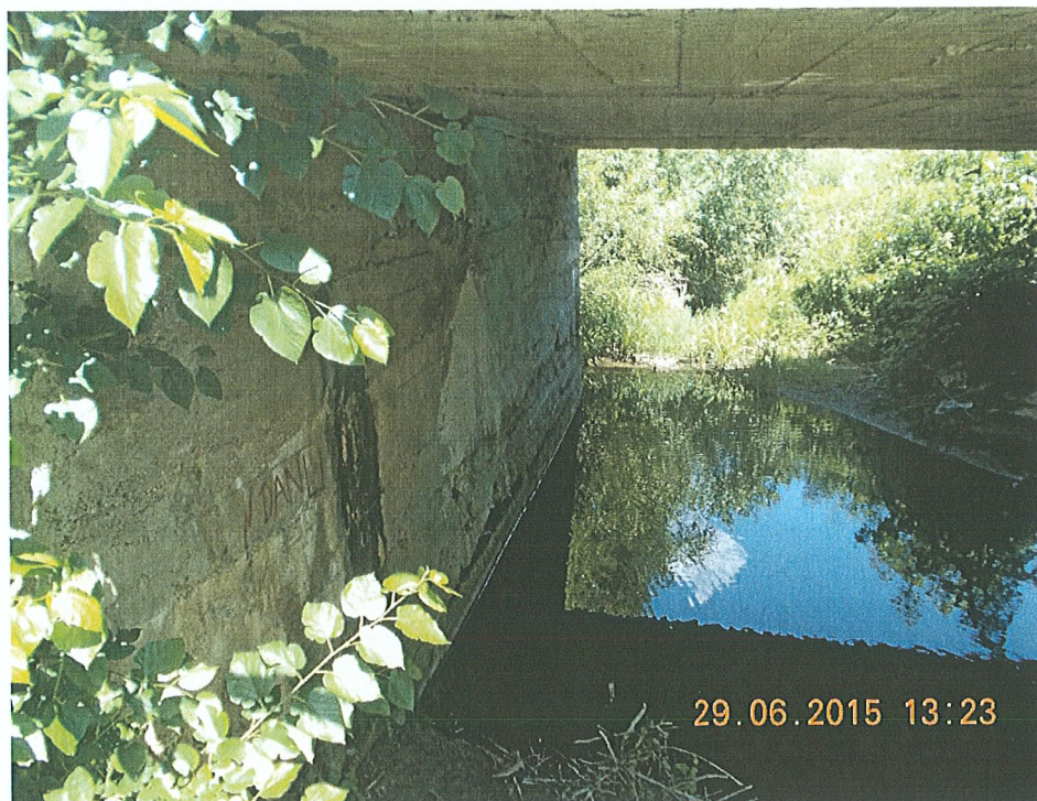
FOTO 3. ALBIE PARTIAL COLMATATA SI BETON ELEVATII CULEI DETERIORAT
