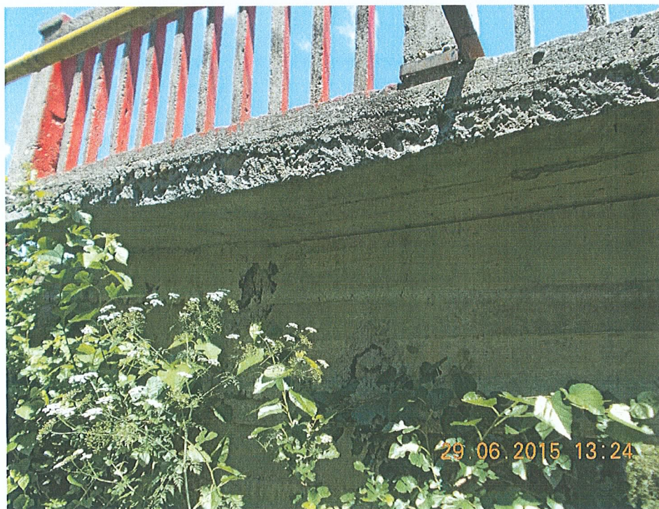
FOTO 4. CONSOLA SI FATA LATERALA DALA DETERIORATE
